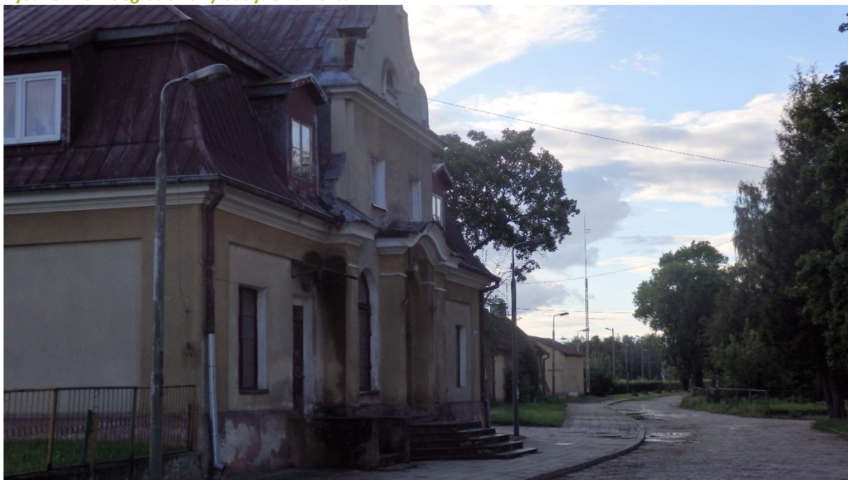
Rysunek 26. Zdegradowany budynek dworca PKP
